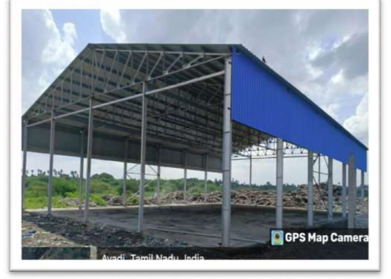
Material Recovery Facilities centre –சேக்காடு
